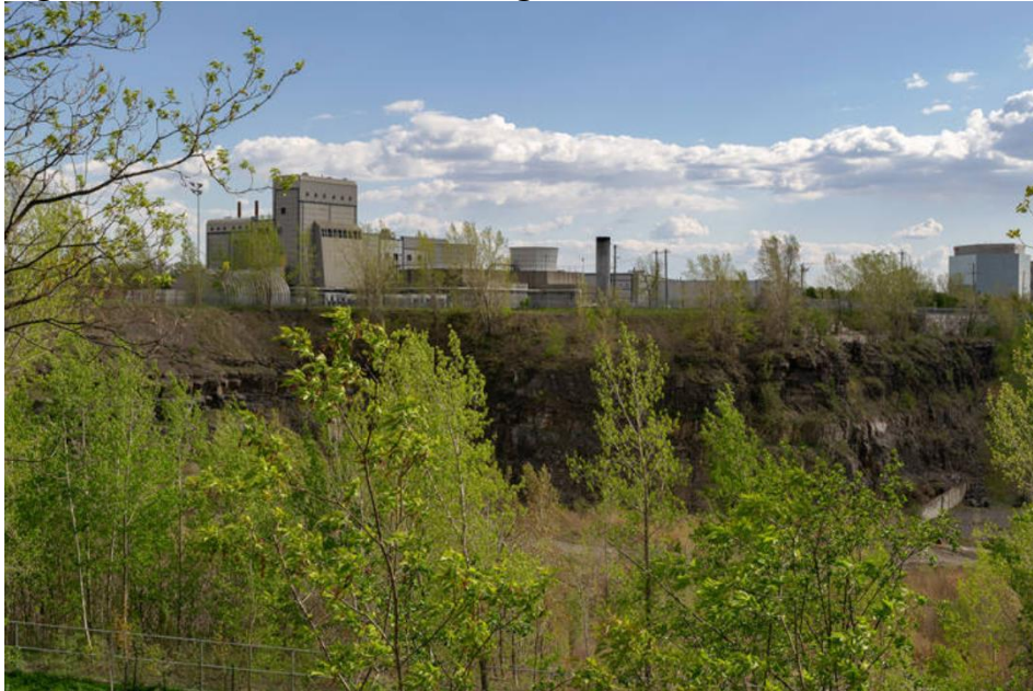
Figure 4. Centrale Biomont au biogaz, carrière Miron, 2021
