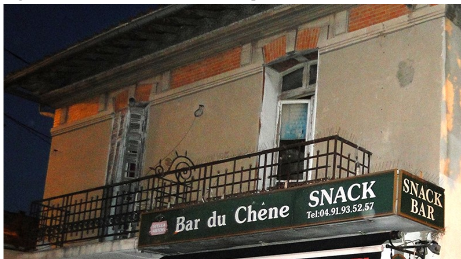
Figure 4. État actuel de l'immeuble Stripoli-Moccia à Beaumont (détail du premier étage)
