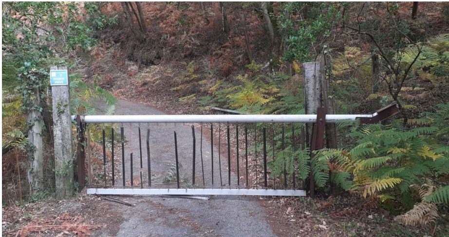
Figure 4. Clôture brûlée après le passage de l'incendie en 2022
