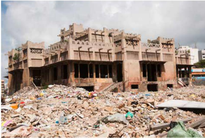
Figure 10 : Destruction du marché Sandaga (2021)
